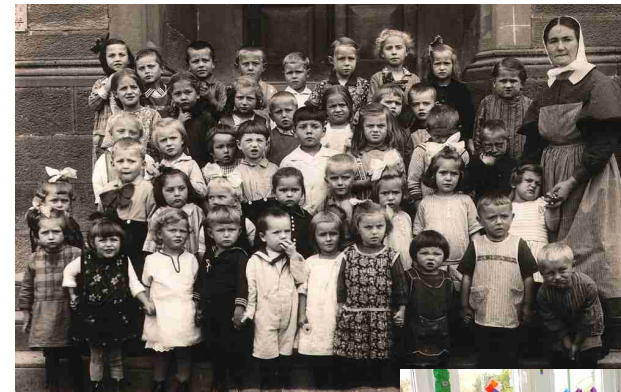
links: Kindergarten Wenkheim in den 1920er Jahren.
